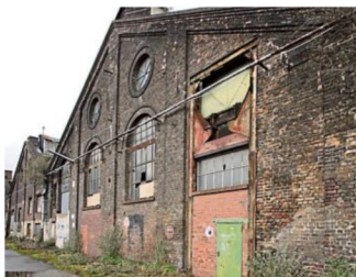
Die Ursprünge der Schwebebahn liegen in diesen Hallen.
